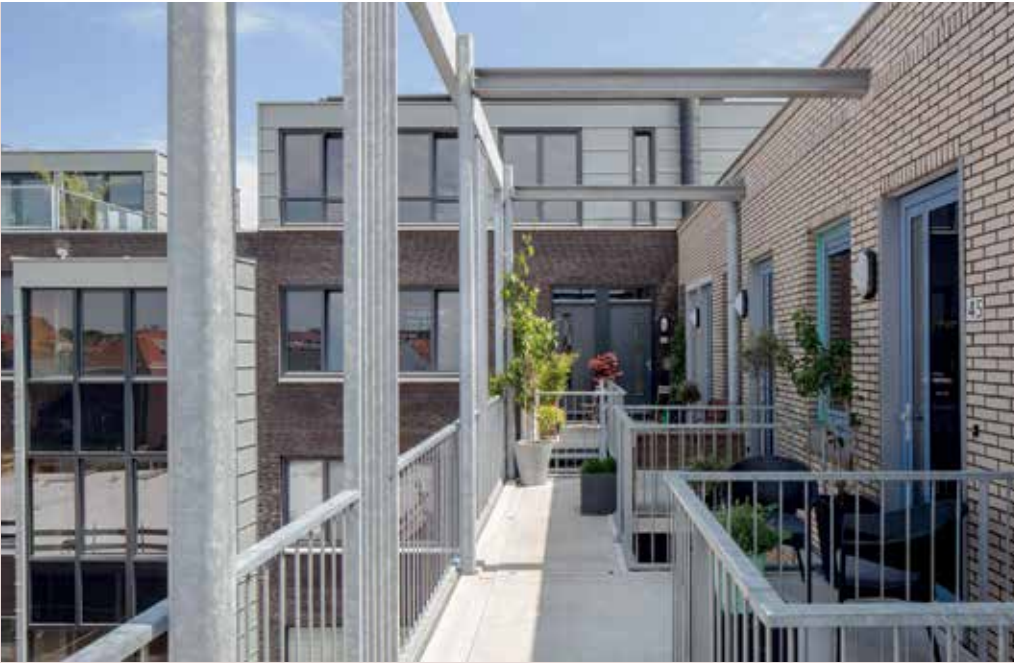
HET BURO IN GOUDA, WAAR DE GALERIJ IS LOSGETROKKEN VAN DE APPARTEMENTEN.
